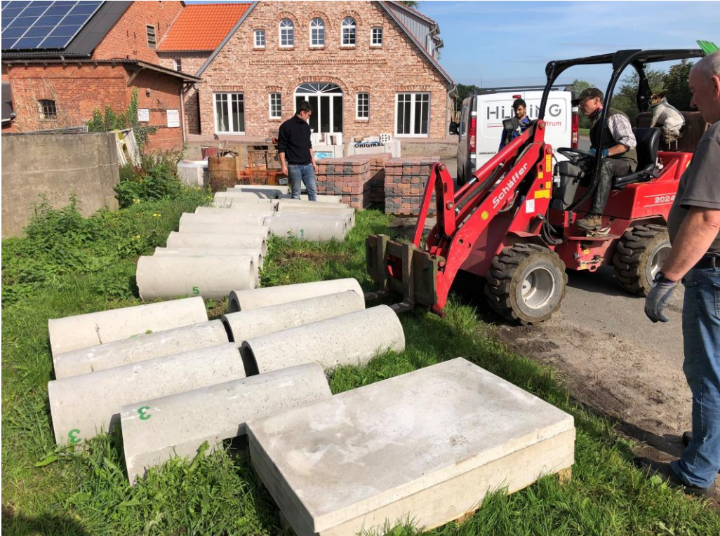
Lieferung und Verteilung neuer Betonrohrfallen
